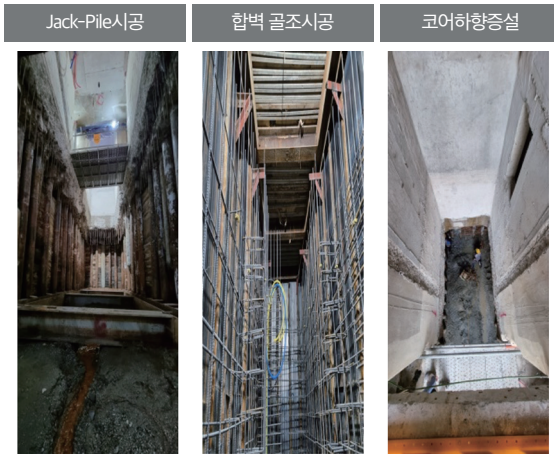
[그림 14] 코어하향 증설 시공사진
