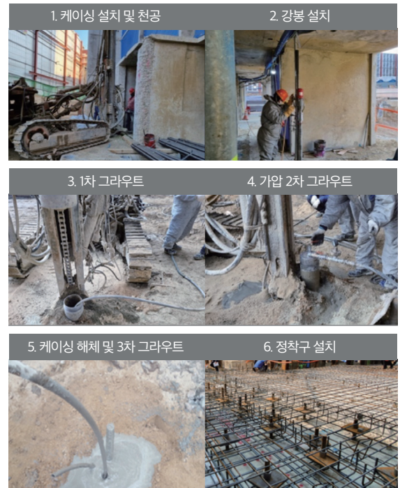
[그림 10] Doctor-Pile 시공과정
