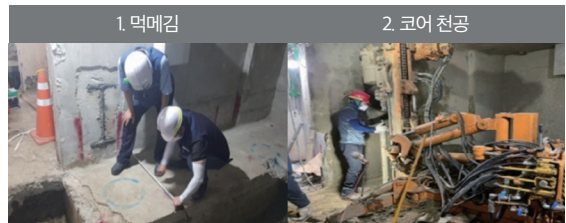
[그림 13] Jack-Pile 시공과정
