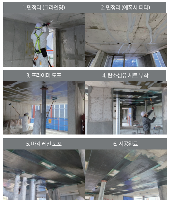
[그림 18] 탄소섬유시트 시공순서
